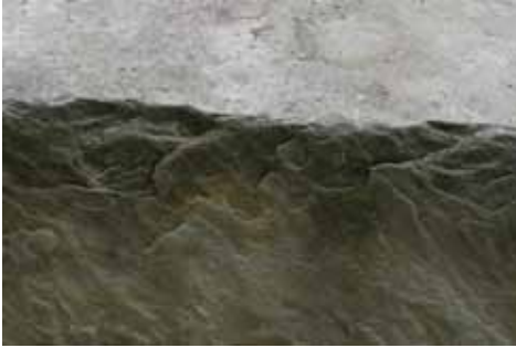
Fig. 6. Exfolieri paralele față de substratul de baza (aspect solzos)
