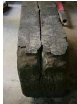
Fig. 4. Fisuri și fragmentări ale corpului petrografic - vedere față
