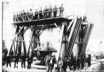
Foto.8: Montarea unei cupole „Grüson” pentru obuzierul de 210 mm fabricată în Germania la Grüson Werke din Buckau-Magdeburg.
