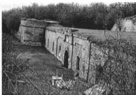
Foto.7: Bateria 1-2 Chitila. Vedere generală a fortificației fotografiată de pe donjonul din dreapta (care adăpotea cupola unuiu din obuzierele de 210 mm).
